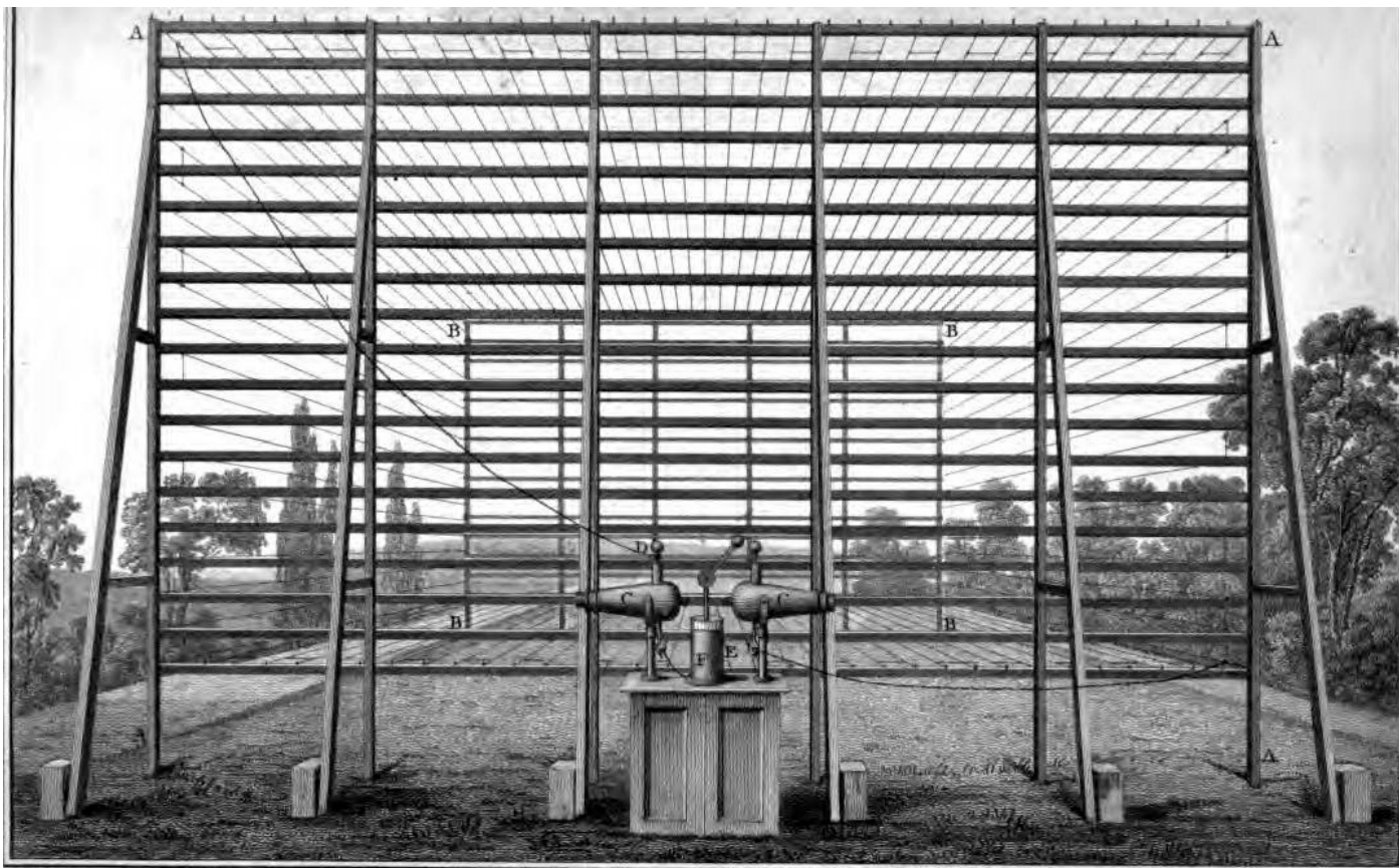
静電気通信の実験のためにフランシス・ロナルドが自宅農場に総延長80マイルにわたって展張した電線。一端にライデン壺からの静電気を加え、他端にその影響が現れることを確認。
